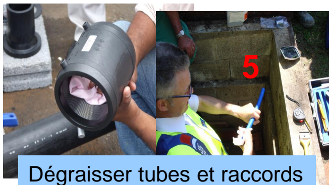
Délimiter zone à gratter, gratter, chanfrein interdit
