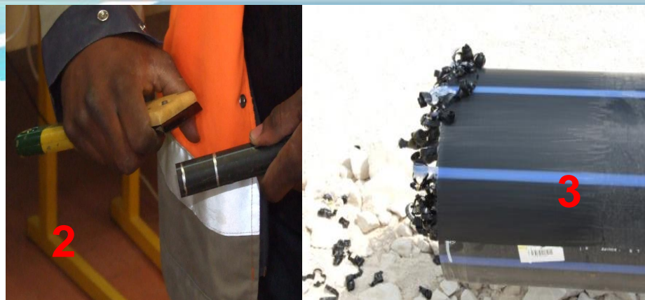
Délimiter zone à gratter, gratter, chanfrein interdit
